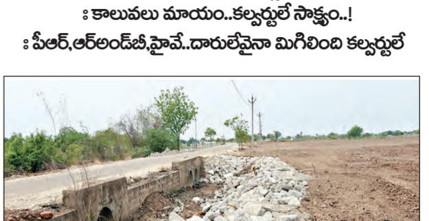
యాడికి-వేములపాడు మధ్య కల్వర్టుకు అడ్డుకట్ట
